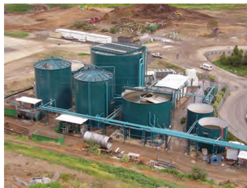
СЛИКА 5-11: Типична постројка за анаеробна дигестија што е дел од постројката за МБТ
