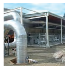
СЛИКА 5-9: Систем за аерација на постројка со затворена комора за компостирање
